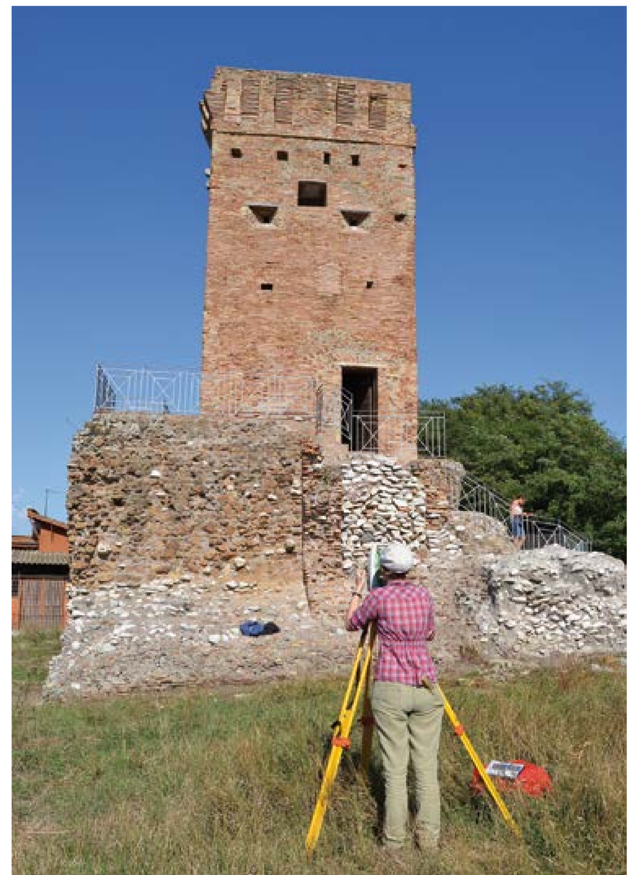
Arbeiten an der Westseite des „Tor Boacciana“
