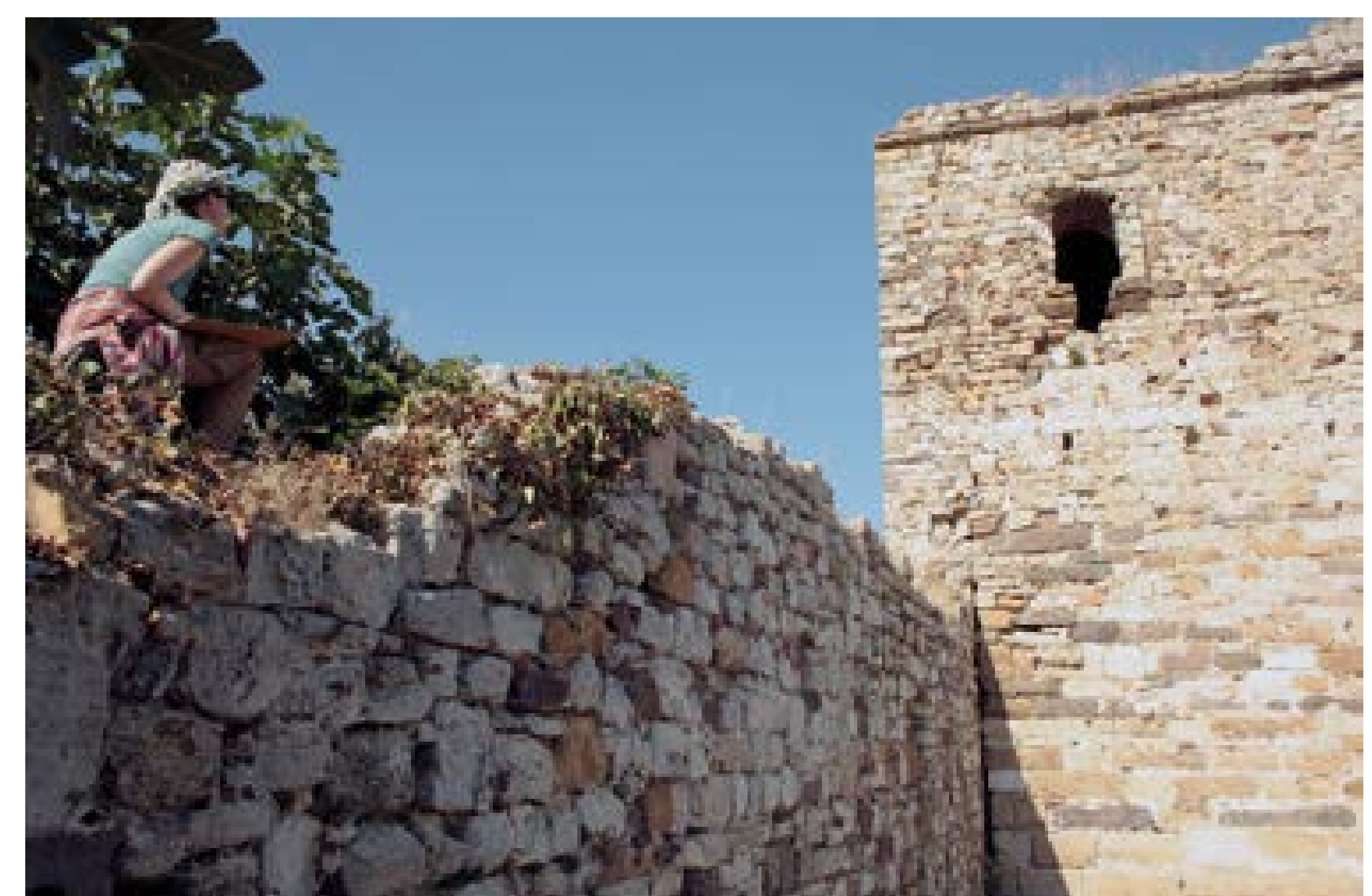
Dokumentation einer Turmfassade. Foto: RGZM
