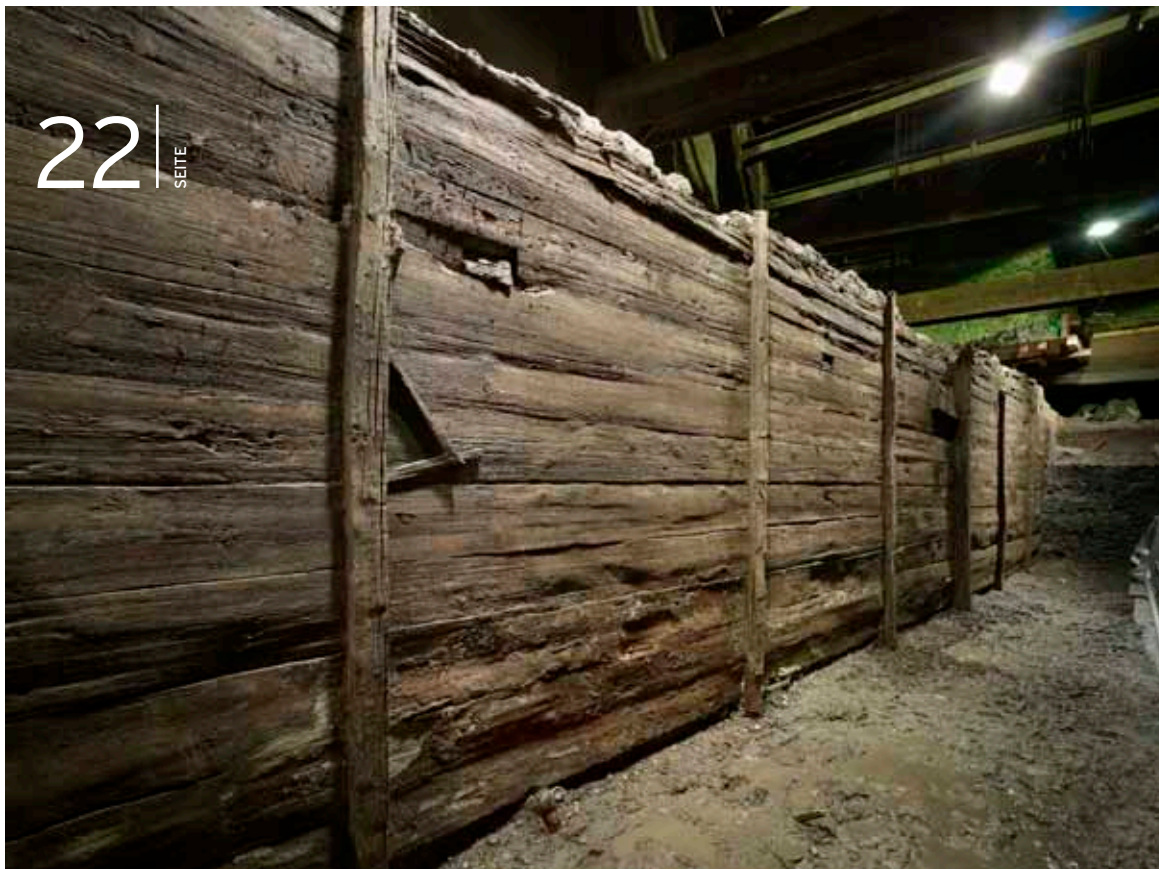
Die Tannenschalung des Gussfundamentes der römischen Stadtmauer verblieb als sogenannte verlorene Schalung im Erdreich. Kurt-Hackenberg-Platz in Köln, Ansicht von der Stadtseite.
